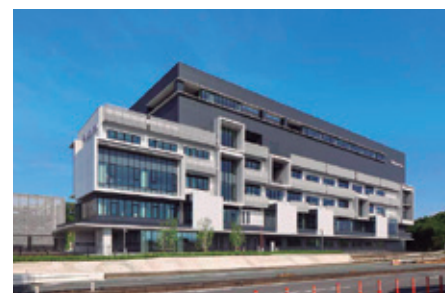
SAGAグローバルリサーチセンター
